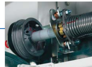
Système d'équilibrage par répartiteurs à torsion.
